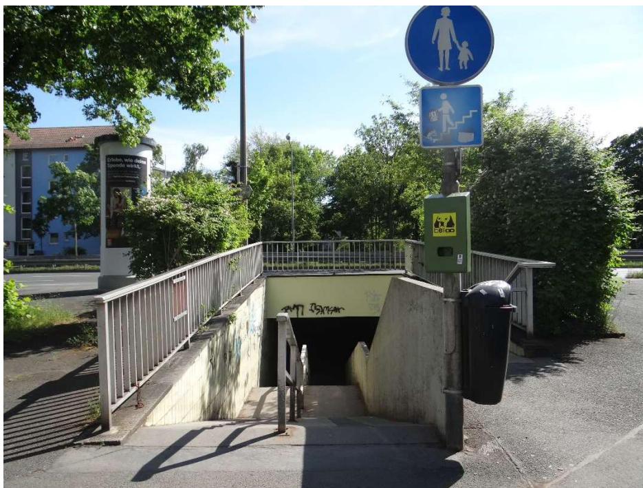
● Abbildung 12: Treppe der Unterführung der Paul-Gossen-Straße
